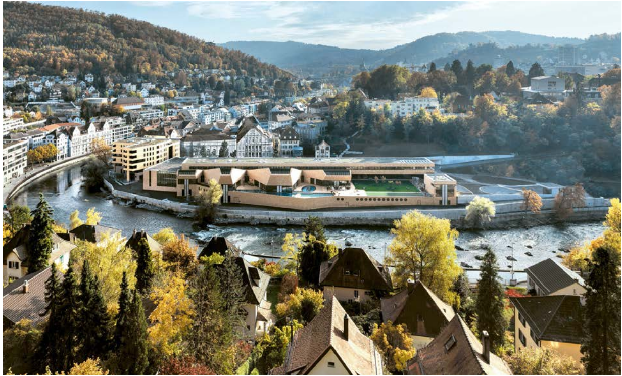
Blick aufs Thermalbad von Ennetbaden aus: Das gelbe Gebäude links ist die «Residenz 47», die Tiefgarage des Badekomplexes reicht bis unter den Park rechts.
